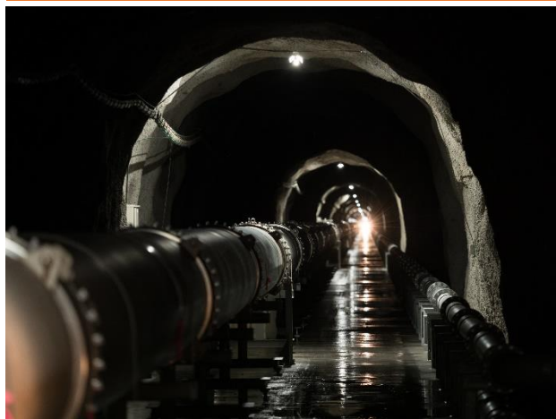
アームが設置されたトンネル（国立天文台 HP より）
